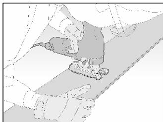
После установки последней доски под окном приложите отлив (не прикрепляя его) и отметьте расположение отлива на доске. Переверните доску и начертите контур подоконника на задней части доски. Оставьте зазор 10 мм между отливом и доской для вентиляции.
