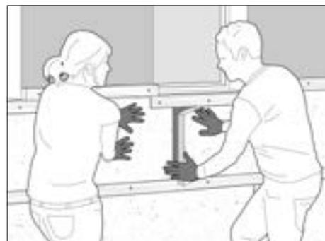
Instale o isolamento num padrão escalonado entre as ripas horizontais e nivelado com a madeira. Evite eventuais intervalos.
