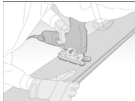
Com a última placa terminada abaixo da janela, poderá colocar o parapeito no lugar (sem fixação) e marcar o sítio onde o parapeito ficará na próxima placa. Vire a placa para cima e faça um esboço do parapeito na parte traseira da placa. Preveja um intervalo de 1 cm entre o parapeito e a placa para ventilação.
