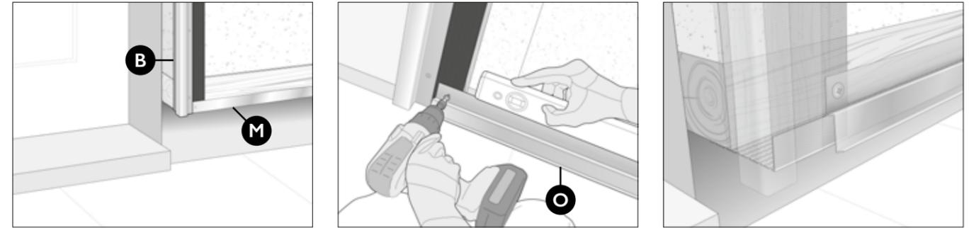
Achten Sie darauf, dass die Unterseite der Eckprofile oder Leibungsprofile (B) unten bündig mit dem Lüftungsprofil (M) abschließt.
