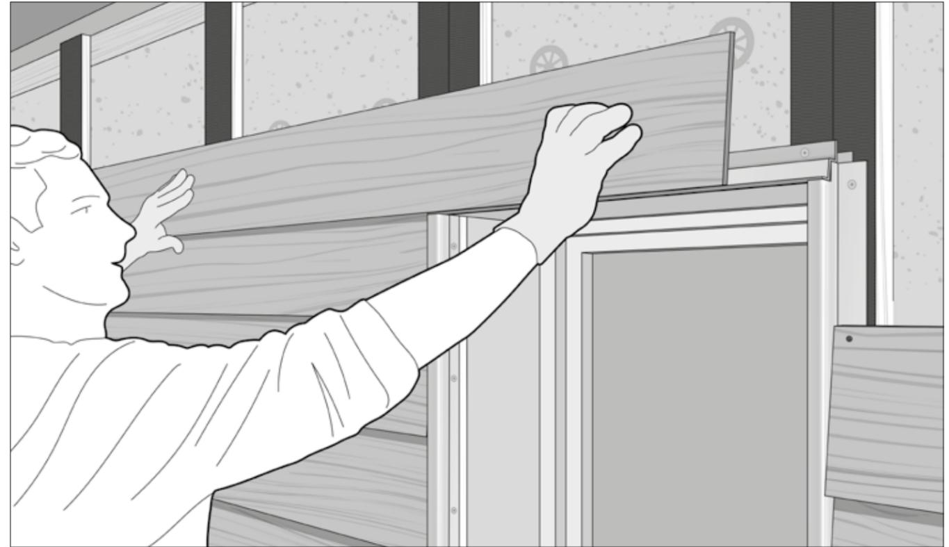
Arbeiten Sie sich neben dem Fenster hoch. Wenn Sie das erste Paneel über dem Fenster erreicht haben, zeichnen Sie die Kontur des Fensters auf die Rückseite des Paneels und schneiden Sie diese mit der Stichsäge aus. Vergewissern Sie sich, dass das Paneel am oberen Rand des Fensters mit den anderen Paneelen im Reihenverlauf übereinstimmt und befestigen Sie dieses dann mit einer Cedral Lap Schraube (H).
