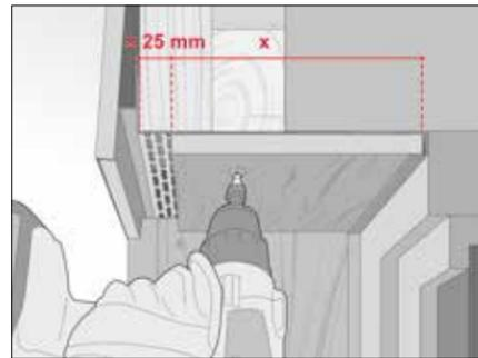
Messen, schneiden und montieren Sie nun ein Fensteranschlussprofil (E) mit dem Kleber und dem Schaumstoffstreifen (G) an der Oberseite der Fensterleibung, wie im Bild dargestellt.
