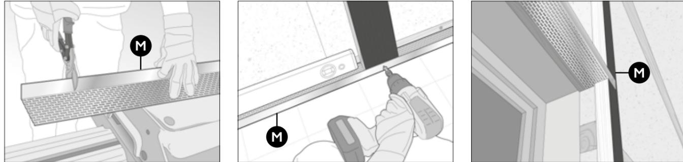
Um die Fassade frei von Kleintieren zu halten, montieren Sie die Lüftungsprofile (M) unten an der Fassade und über den Fenstern und Türen. Achten Sie darauf, dass alle Spalte größer als 15 mm mit den Lüftungsprofilen geschlossen werden.
