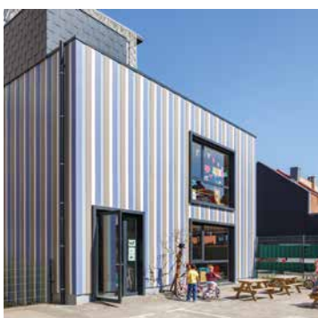
Construction ludique avec pose verticale
