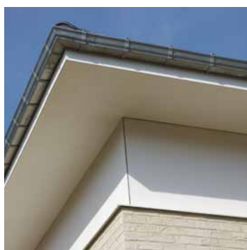
Finition d'un porte-à-faux
